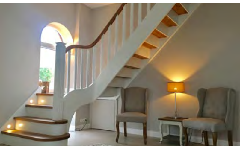
Weiße, geschlossene Treppe mit Stufen und Handläufen aus geöltem Ebenholz und liegenden Edelstahlgurten sowie LED-Lichtern
