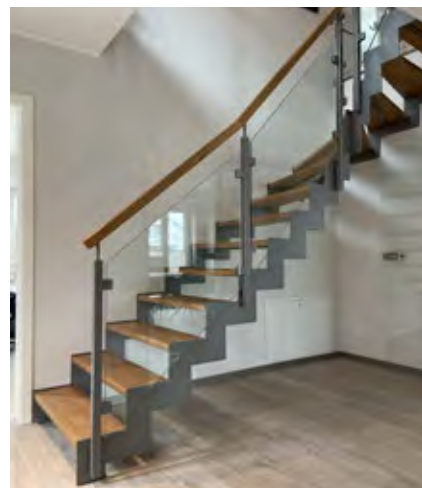
Flachstahl-Wangentreppe mit Eichenstufen, Glasgeländer, eckigem Holzhandlauf und quadratischen Stahlposten
